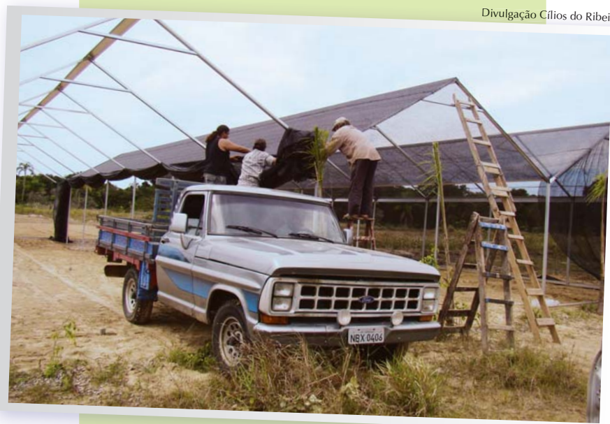
Área onde está sendo construído o Viveiro
